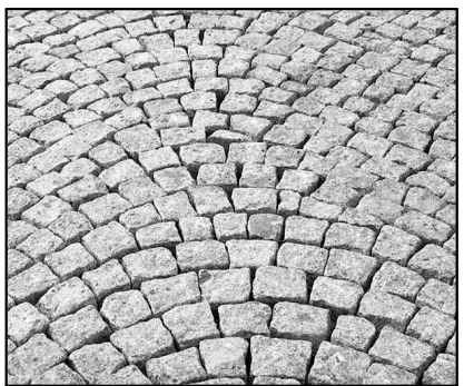
Projektowana warstwa wykończeniowa - kostka granitowa o wymiarze ok. 10x10cm np. szara
