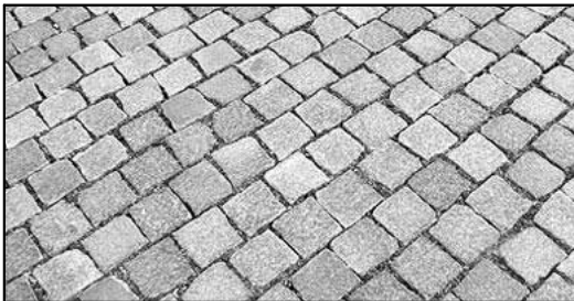
Projektowana warstwa wykończeniowa - kostka granitowa o wymiarze ok. 12x12cm układana w rybią łuskę np. grafitowa
