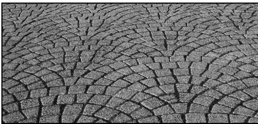
Projektowana warstwa wykończeniowa - kostka granitowa o wymiarze ok. 12x12cm układana w rybią łuskę np. grafitowa
